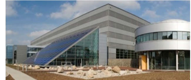
Stade: Automatisierung und Produktionstechnik Forschungszentrum CFK Nord
