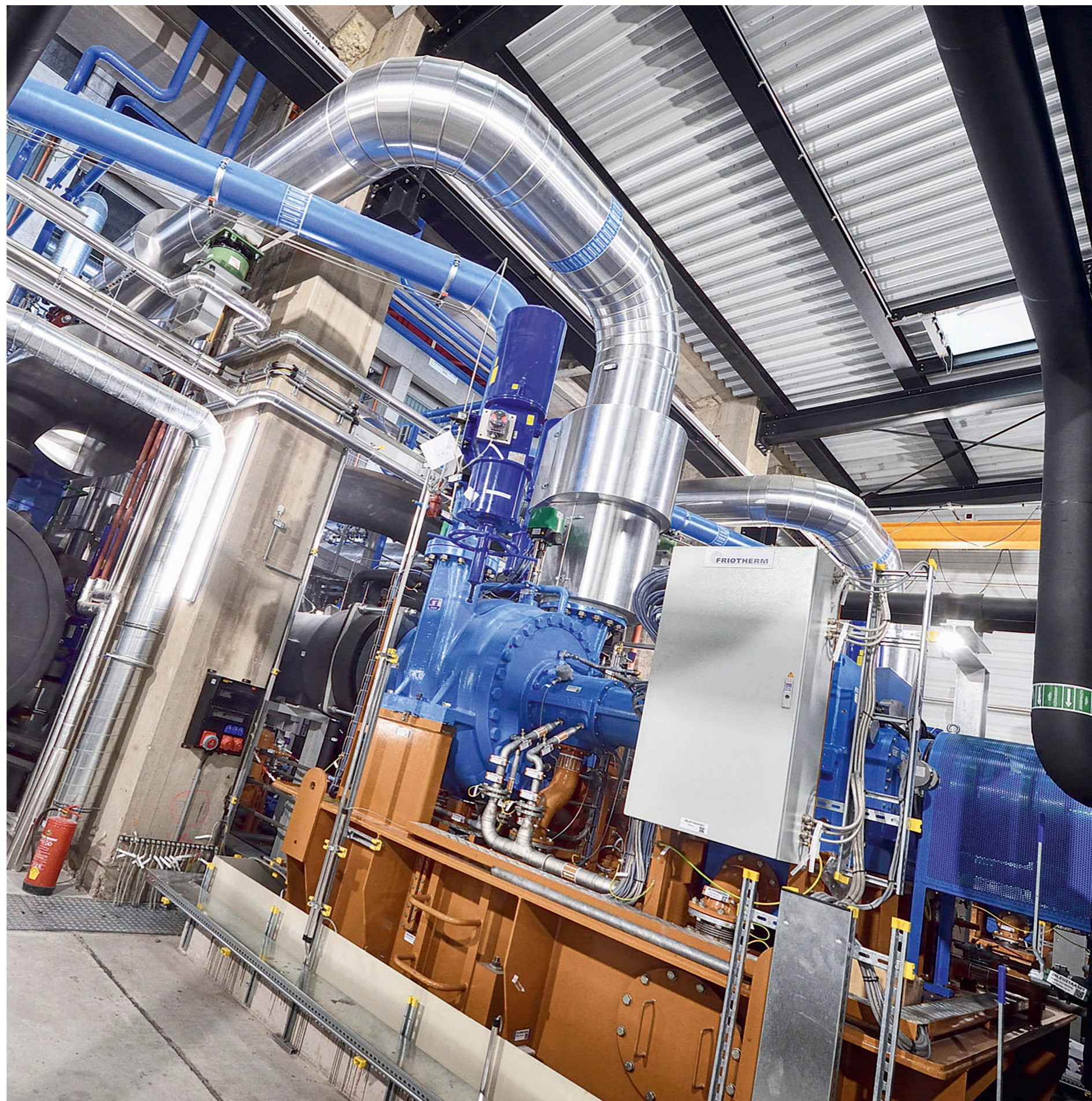
Eine der grössten WP Europas mit einer thermischen Leistung von rund 40 Megawatt pumpt seit dem März 2019 in Wien: Beim Kraftwerk Wien Simmering wird die Abwärme von Kraftwerksanlagen genutzt, um 25000 Haushalte mit CO 2 -freier Fernwärme versorgen zu können.
