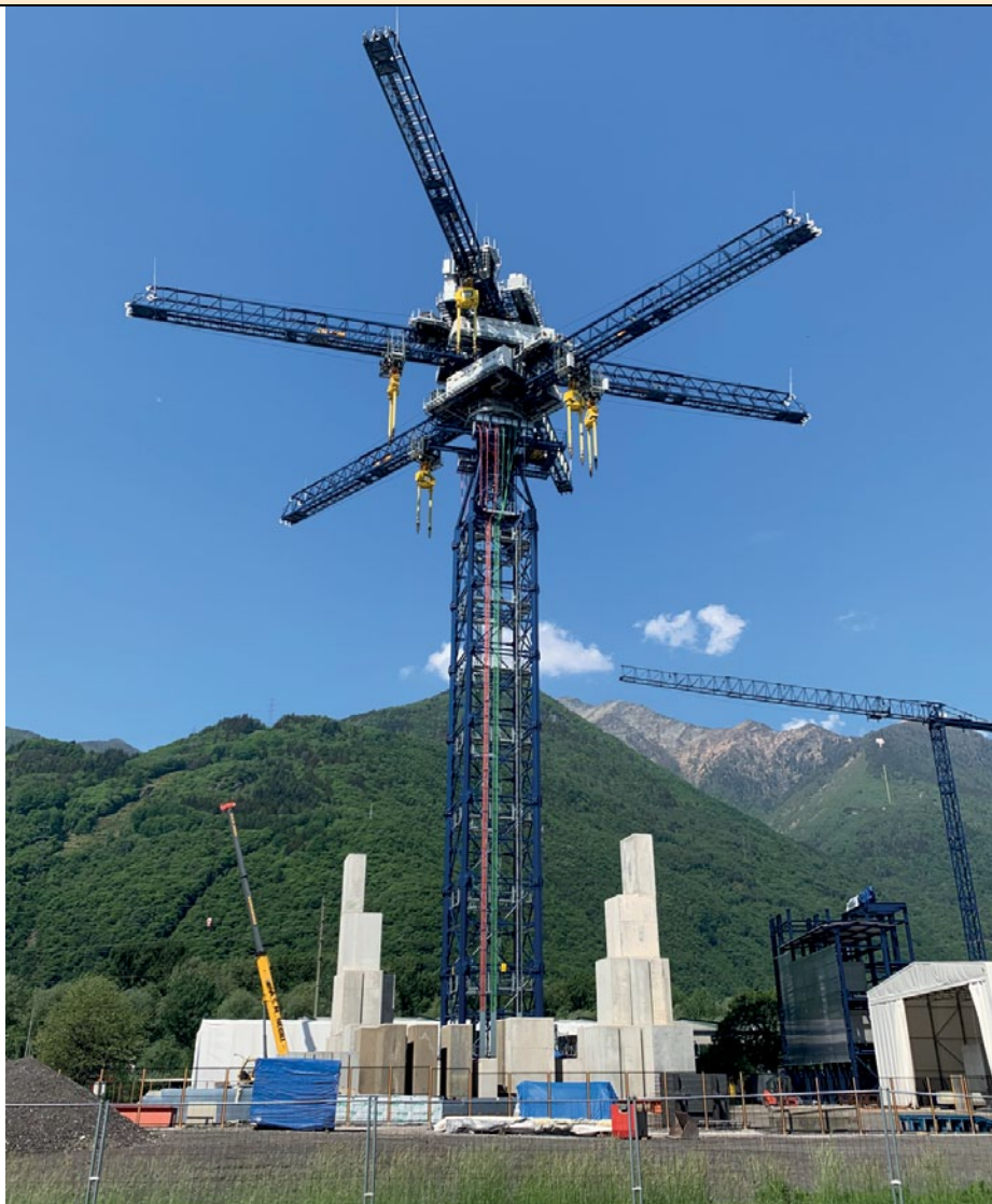
Sogenannte Gravitationspeicher wie der sechsarmige Kran in Castione-Arbedo können als Kurzzeitenergiespeicher herhalten.
