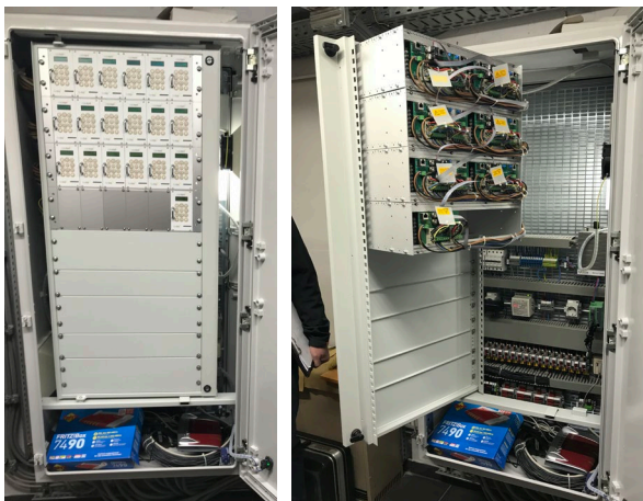
Abb. 1.14 Schutzstromgerät für 19 Schutz zonen
